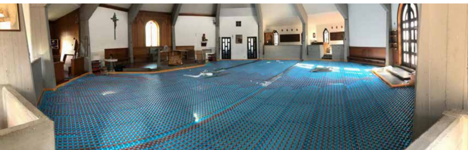
Chiesa | Roma - Impianto radiante a pavimento con pannello Variplus
